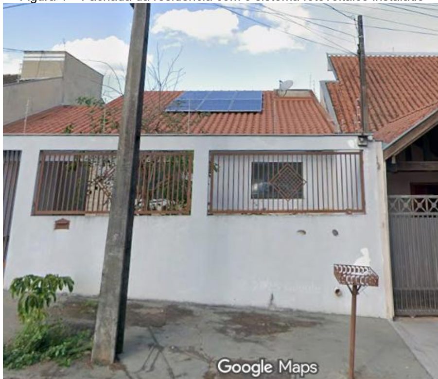
Figura 4 – Fachada da residência com o sistema fotovoltaico instalado
